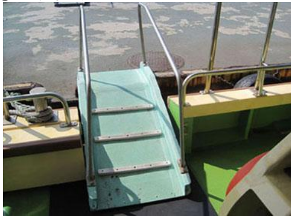
④ 干潮時の岸壁との段差
